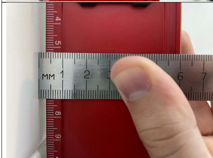
Фото №12. Измерение уровня стен в санузле в квартире.
