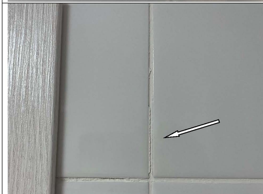
Фото №47. Затирка швов настенной керамической плитки в санузле.
