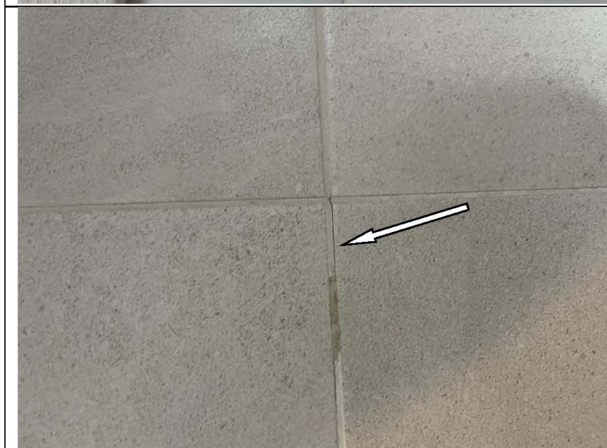
Фото №48. Затирка швов напольной керамической плитки в ванной комнате.
