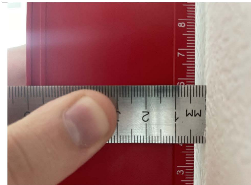
Фото №7. Измерение уровня стен в кухне в квартире.
