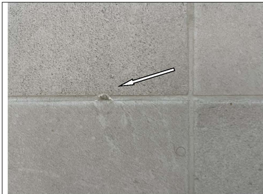
Фото №49. Затирка швов напольной керамической плитки в коридоре.
