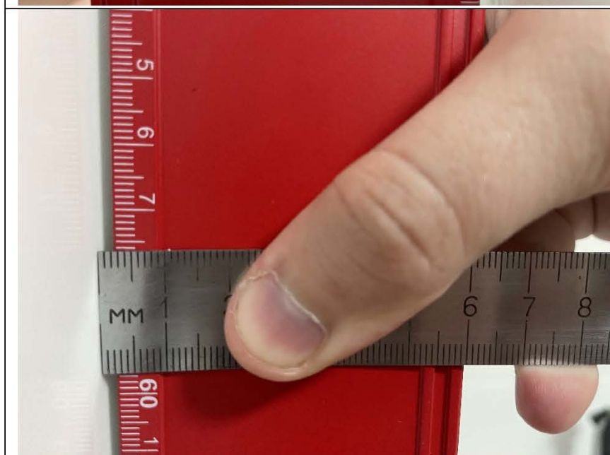
Фото №11. Измерение уровня стен в ванной комнате в квартире.
