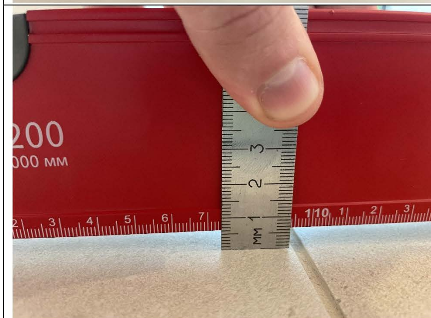
Фото №17. Измерение напольного покрытия из керамической плитки в коридоре в квартире.
