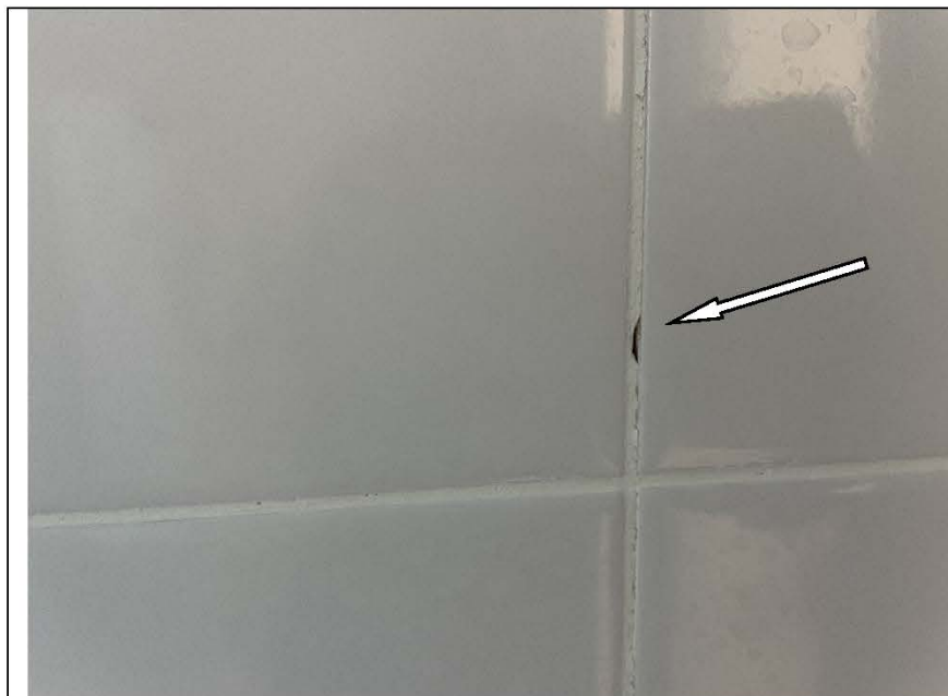
Фото №46. Затирка швов настенной керамической плитки в ванной комнате.
